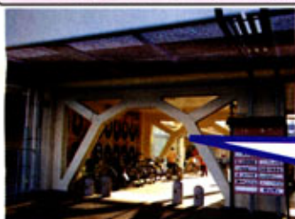
ピロティ部分を鉄骨ブレースで補強
