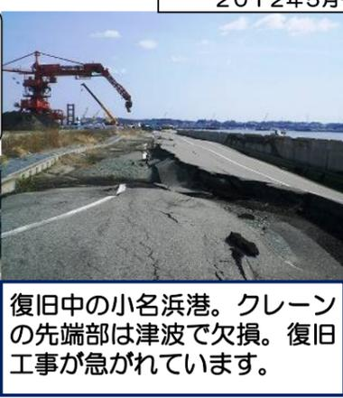
復旧中の小名浜港。クレーンの先端部は津波で欠損。復旧工事が急がれています。
